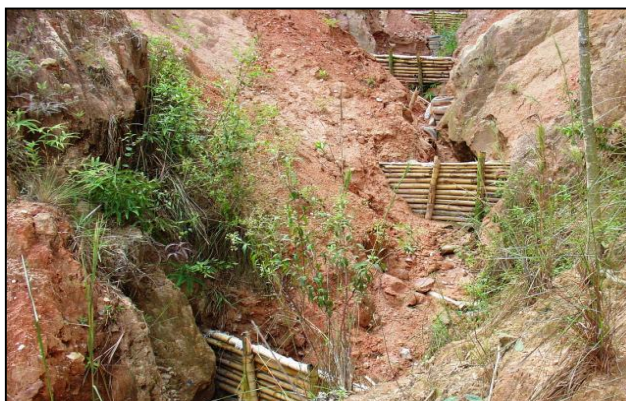
Figura 15.7 - Exemplo de paliçadas rústicas no processo inicial de retenção dos sedimentos (EMBRAPA, 2015)
