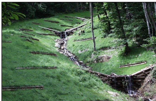
Figura 15-8 - Aplicação integrada de paliçadas ao projeto paisagístico de recomposição ambiental (VERTICAL GREEN, 2022)
