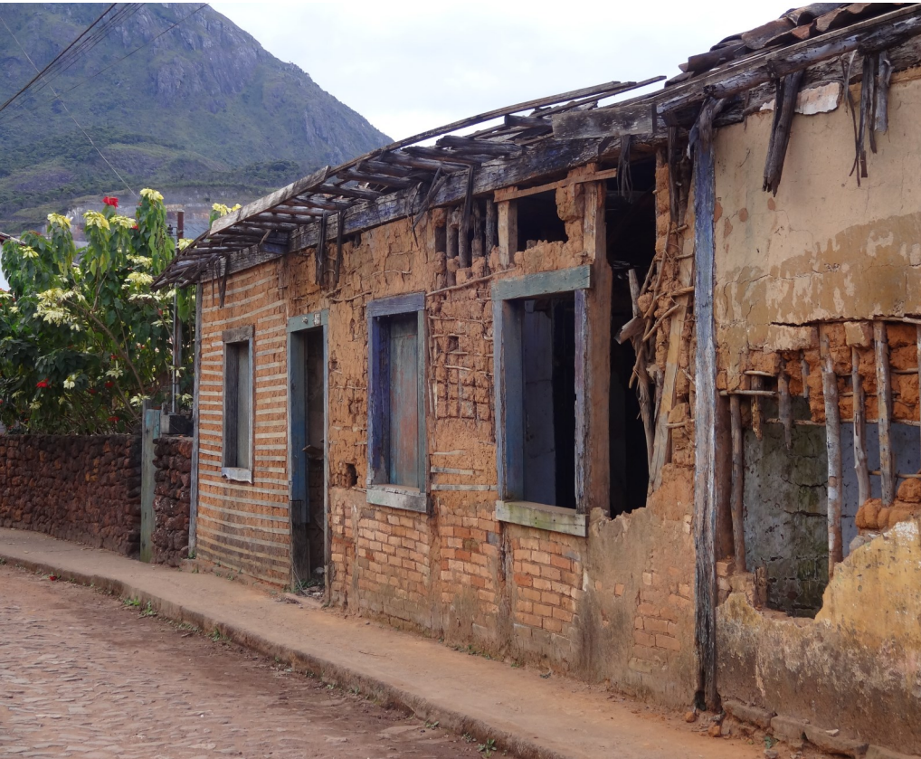
EDIFICAÇÃO DE PAU A PIQUE EM MORRO D’ÁGUA QUENTE
