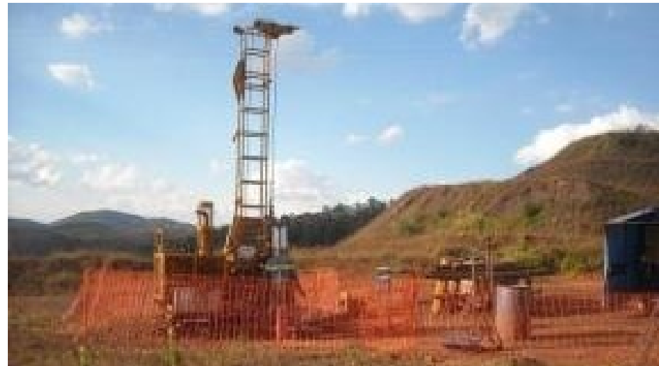
Atividades de sondagem geotécnica
