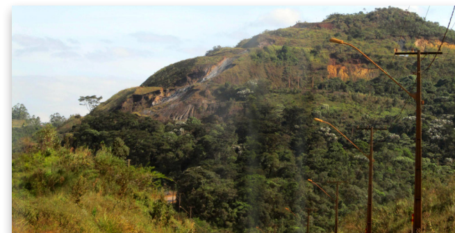
Processo erosivo nos taludes
