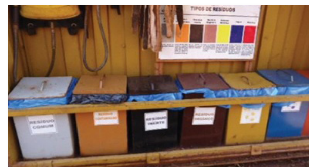
Sistema de acondicionamento de resíduos em praças de sondagem
