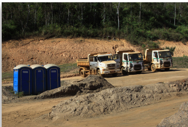
Atividades de manutenção na área da Mina Del Rey
