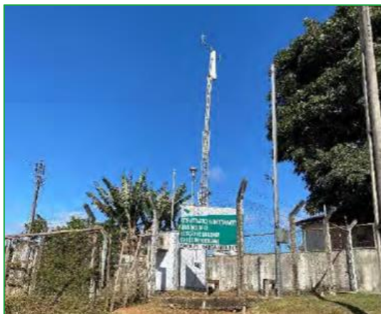
Vista da Estação de Monitoramento
