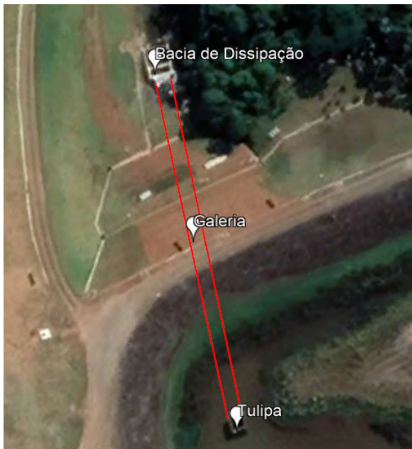
Vertedouro Existente Tipo Poço e Galeria da Barragem Quinzinho na condição anterior à implantação do sistema do vertedouro de soleira livre.
