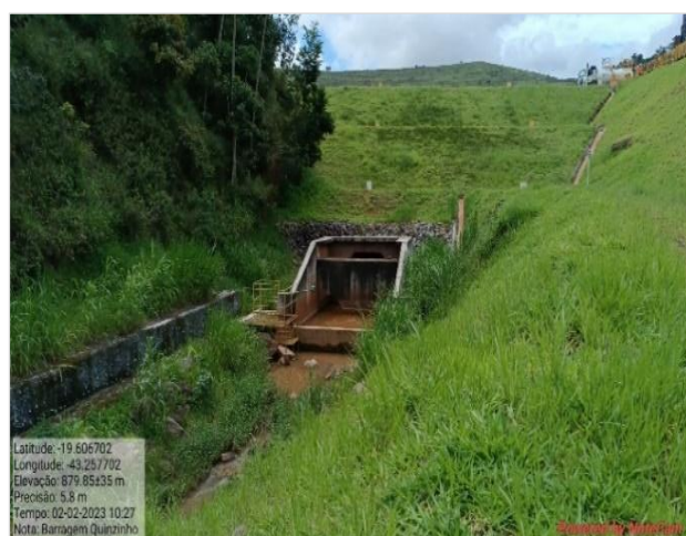
Figura 4-3 - Poço de tomada d'água (tulipa) e saída da galeria do sistema extravasor da Barragem do Quinzinho nas condições anteriores à implantação do sistema do vertedouro de soleira livre.
