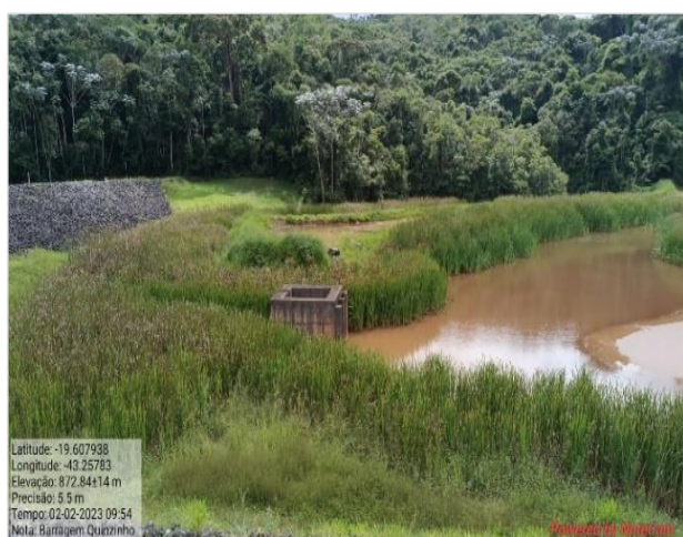
Figura 4-3 - Poço de tomada d'água (tulipa) e saída da galeria do sistema extravasor da Barragem do Quinzinho nas condições anteriores à implantação do sistema do vertedouro de soleira livre.
