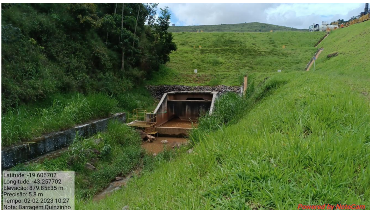
Figura 2.3 – Saída da Galeria do Sistema Extravasor da Barragem Quinzinho.
