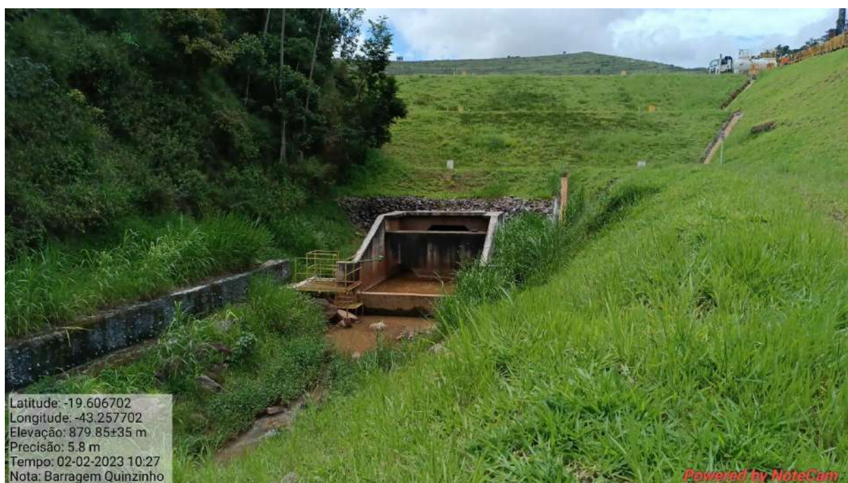
Figura 3: Galeria de saída do sistema extravasor atual.
