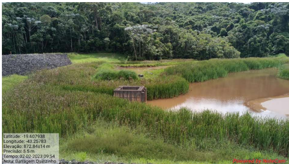
Figura 2: Torre de captação do sistema extravasor atual
