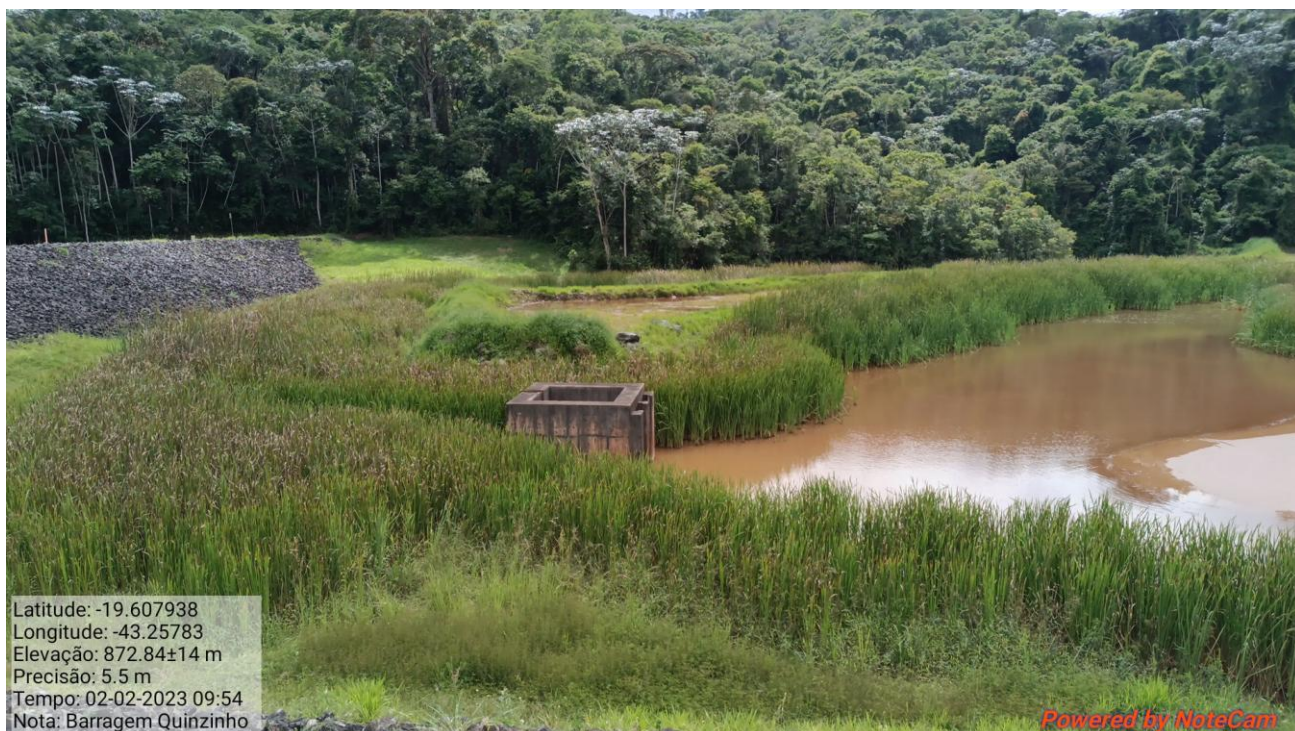
Figura 2.2 – Poço de Tomada d'Água do Sistema Extravasor Existente da Barragem Quinzinho.
