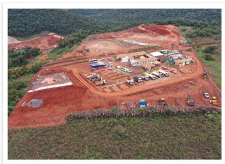
Canteiro de obras em janeiro de 2024 Vale, 2024
