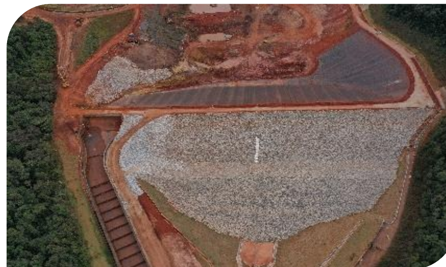
Vista da barragem após as obras Fonte: VALE, 2024
