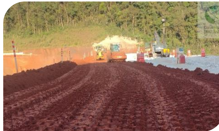
Registro do espaldar de argila (compactação) Fonte: VALE, 2023
