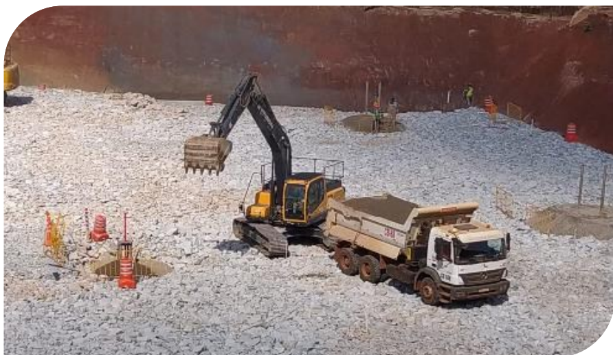
Registro das atividades de enrocamento no reservatório Fonte: VALE, 2023
