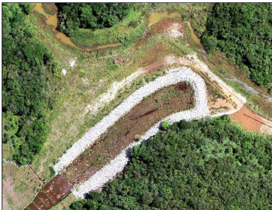
Figura 1-3 – Bacia de dissipação do sistema extravasor da Barragem Timbopeba.
