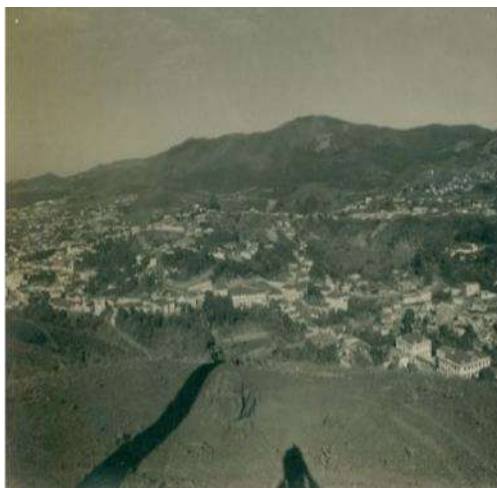
Figura 148 - Vista de sede de Itabira em 1950. Fonte: IBGE, 2023
