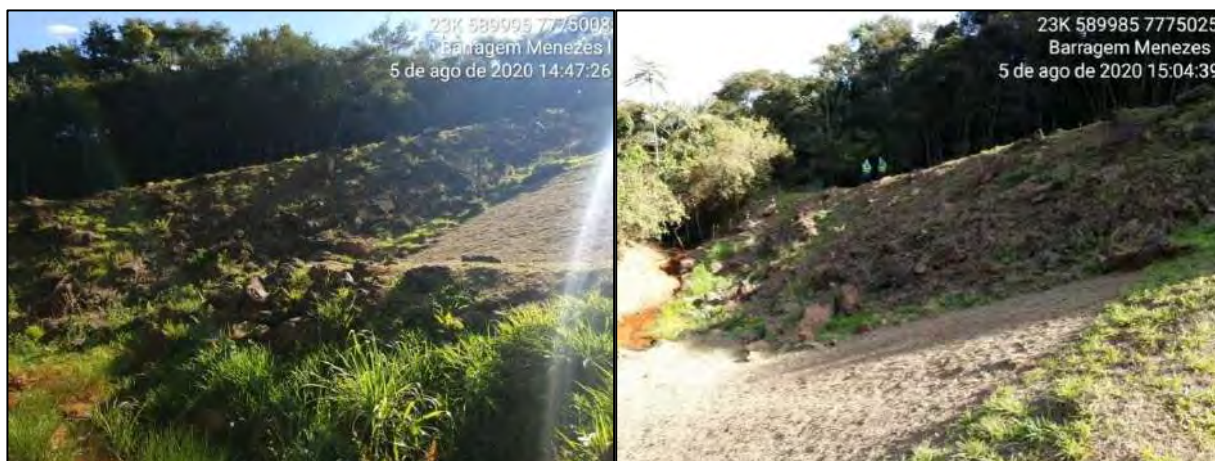
Figura 4-7 – Vista de aterro localizado ao lado do extravasor, no talude de jusante da barragem, contendo blocos de até ~2 metros de litotipos variados (bloco de canga e rocha gnáissica).
