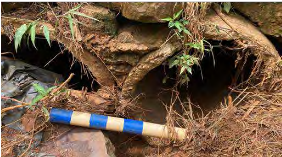
Figura 8.1: Emboque do Bueiro Duplo Tubular de Concreto da Cava da Mina Córrego do Feijão (Fonte: THEMAG, 2022).
