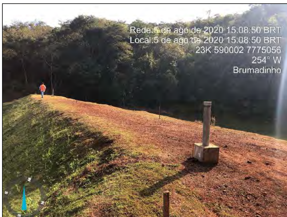
Figura 4-3 – Vista 01 da crista da barragem, com mata densa em sua margem direita.
