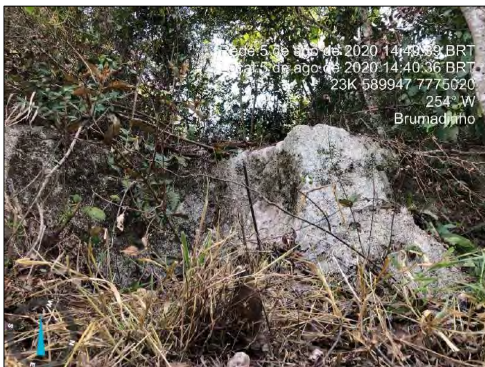
Figura 4-14 – Detalhe da Figura 4.12, com solo residual silto arenoso na ombreira direita a jusante da barragem.
