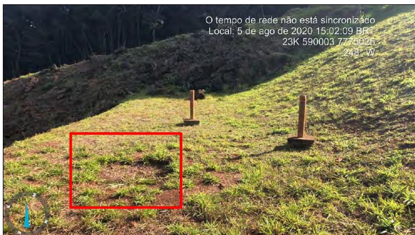
Figura 4-10 – Detalhe da região da berma onde ocorreu a retirada do bloco indeformado.
