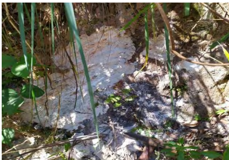
Foto 4.7 - Saprolito de Gnaiss identificado no acesso a barragem de Menezes 1
