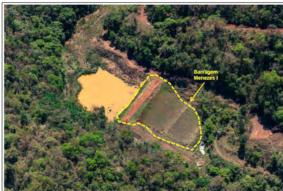
Figura 2.3–Vista geral da Barragem Menezes I.
