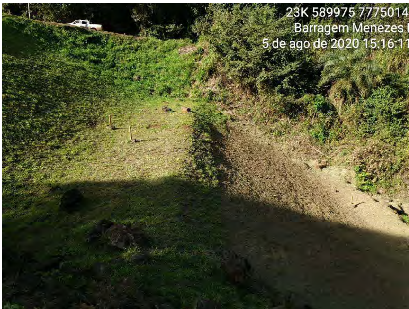
Figura 4-6 – Vista do talude de jusante com uma berma intermediária.
