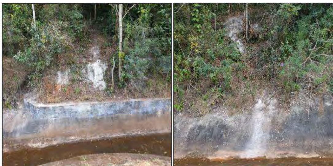
Foto 4.1 - Solo de Alteração de Gnaiss exposto na região da ombreira direita
