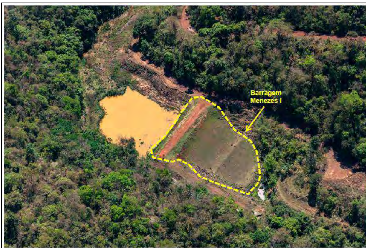
Figura 3.2–Vista geral da Barragem Menezes I.
