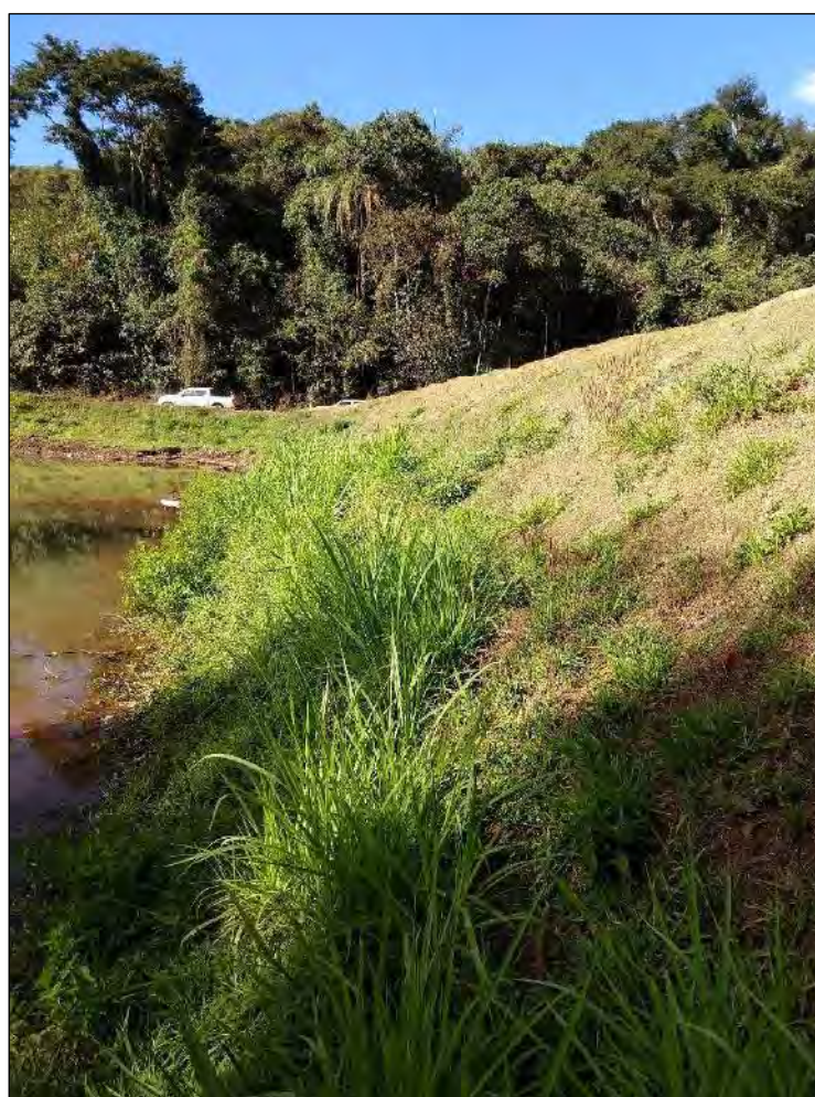
Figura 4-5 – Vista do talude de montante, a partir do emboque do extravasor.
