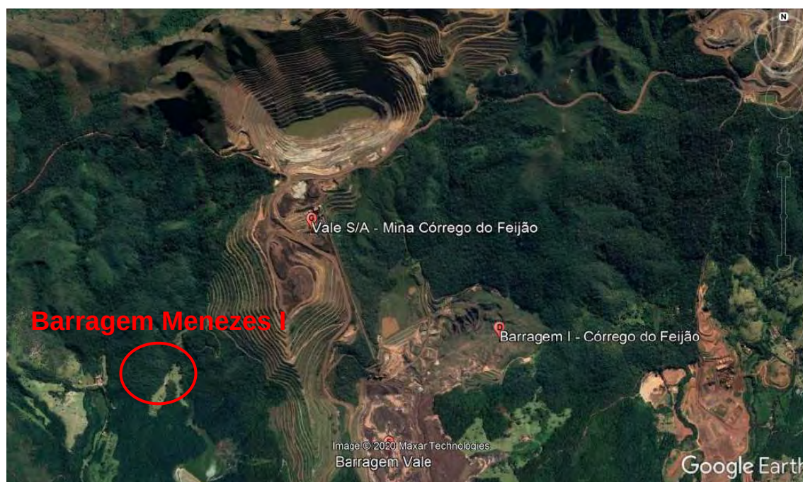
Figura 2.1 – Localização da Barragem Menezes I (Google Earth).
