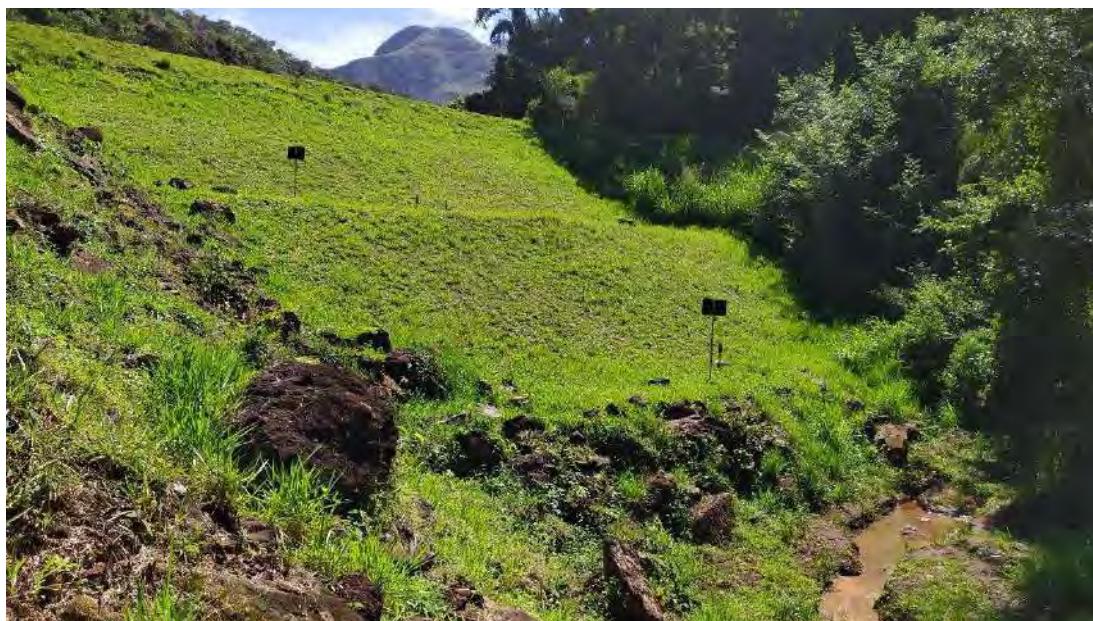
Foto 4.4 - Vista de Jusante para montante do barramento a partir da Ombreira Direita.
