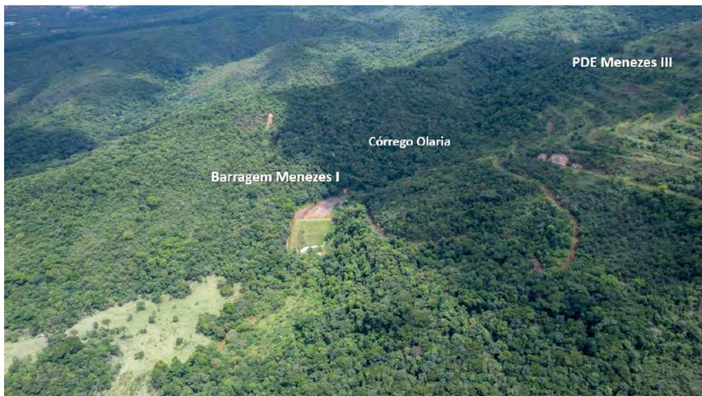
Figura 3-1 - Fotografia área da barragem Menezes I.
