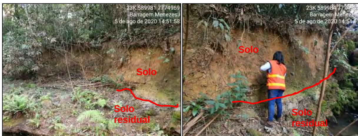
Figura 4-16 – Vista da ombreira direita localizada a jusante do limite do extravasor, contendo solo em contato com solo residual gnáissico.
