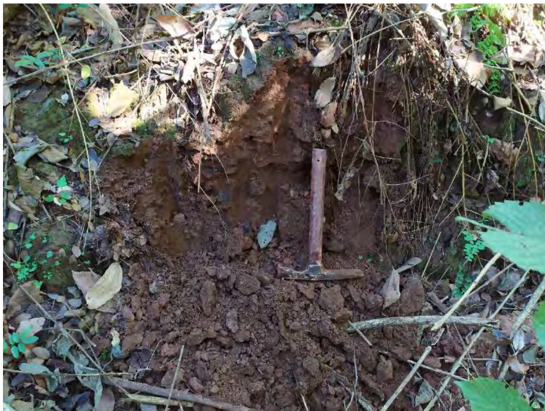
Foto 4.8 - Colúvio identificado na região da ombreira esquerda com presença de grãos e concreções lateríticas.
