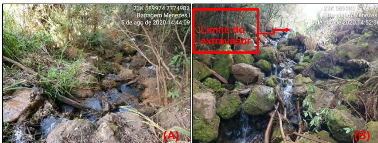
Figura 4-15 – (A) Vista de cima para baixo dos blocos localizados a jusante do extravasor. (B) Vista de baixo para cima dos blocos localizados a jusante do extravasor.
