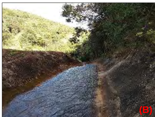
Figura 4-21 – Fotos do extravasor situado junto à ombreira direita: (A) emboque, visto por jusante e (B) canal rápido, visto por montante.
