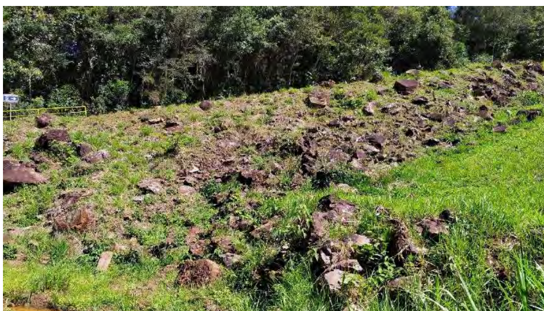
Foto 4.2 - Blocos lançados na região próxima a ombreira direita do barramento
