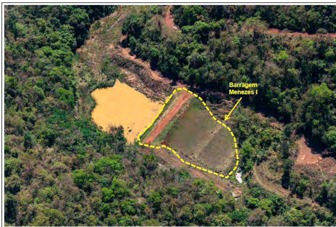
Figura 3-2 – Vista geral da Barragem Menezes I.
