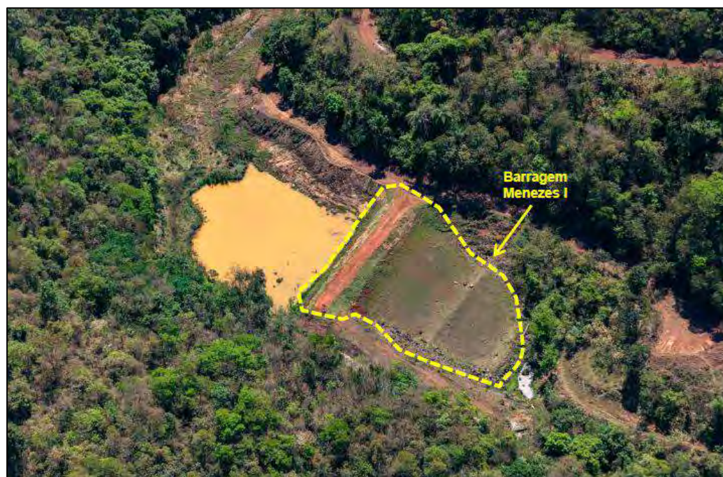
Figura 3.2 – Vista geral da Barragem Menezes I.
