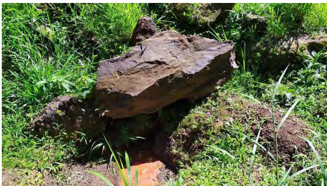
Foto 4.3 - Detalhe dos blocos de Formação Ferrífera lançados na região próxima ao extravasor
