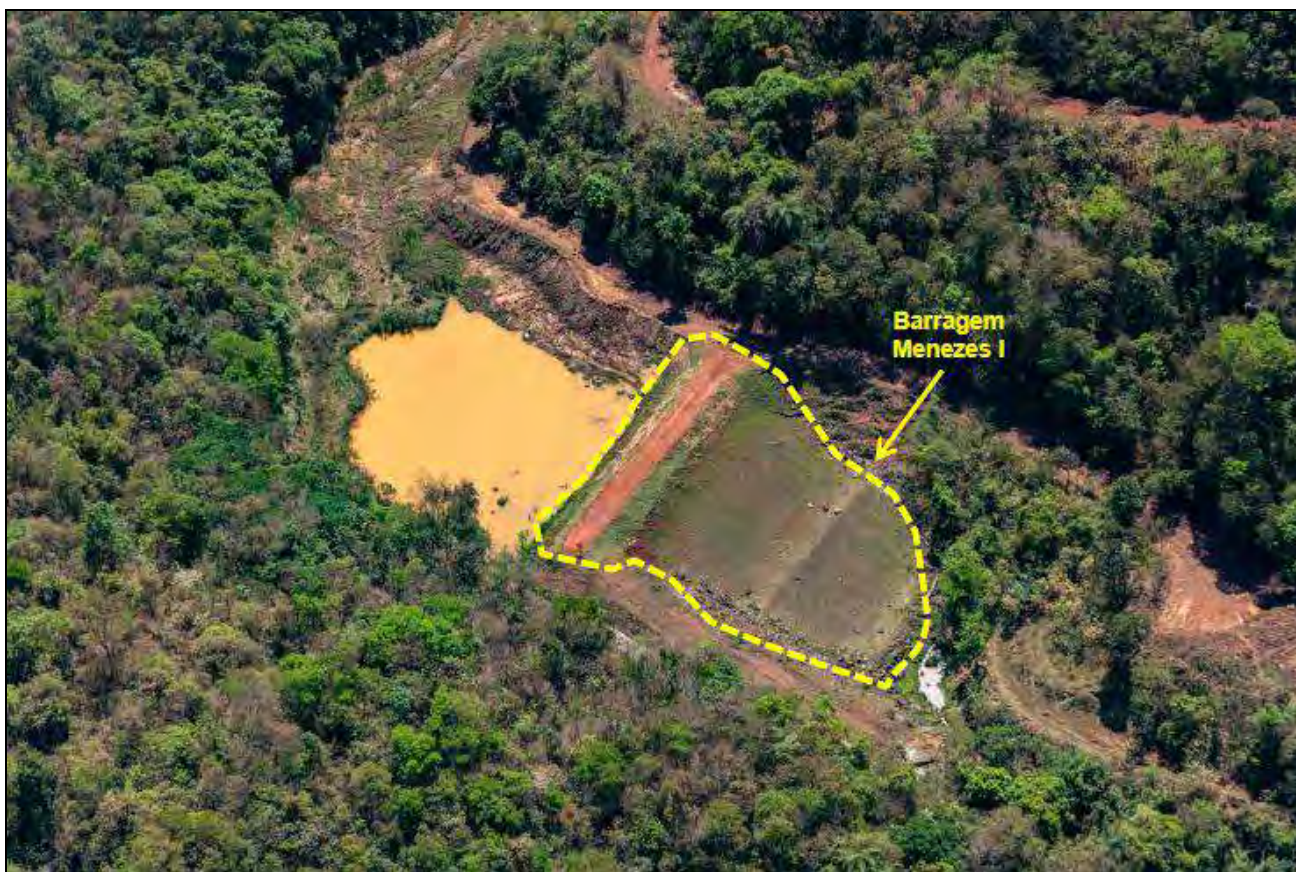
Figura 3-2 – Vista geral da Barragem Menezes I.
