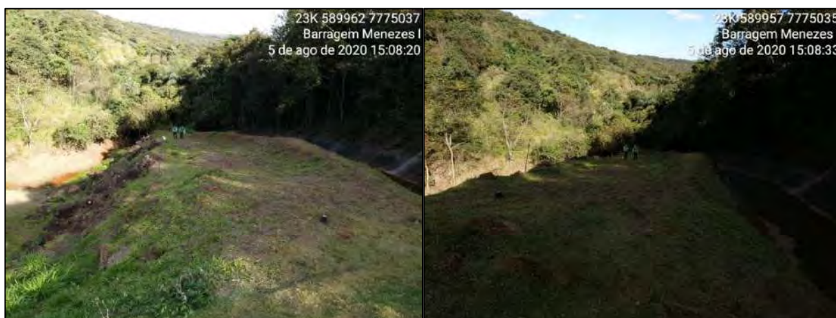
Figura 4-8 – Aterro entre a barragem e o canal extravasor (margem direita, talude de jusante da barragem). Lado esquerdo do aterro com blocos e lado direito com extravasor.
