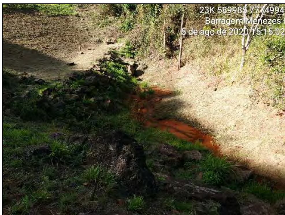
Figura 4-32 – Dreno de fundo no pé da barragem.
