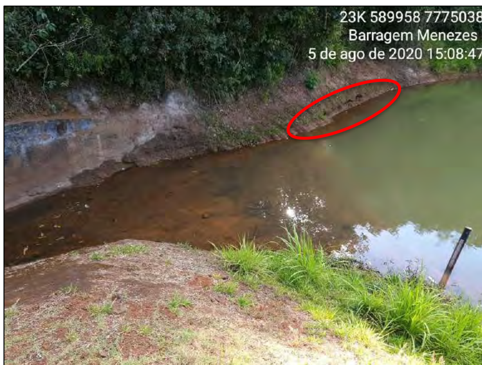
Figura 4-20 – Vista do início do extravasor e de parte do reservatório. Em destaque, assoreamento na margem do reservatório.
