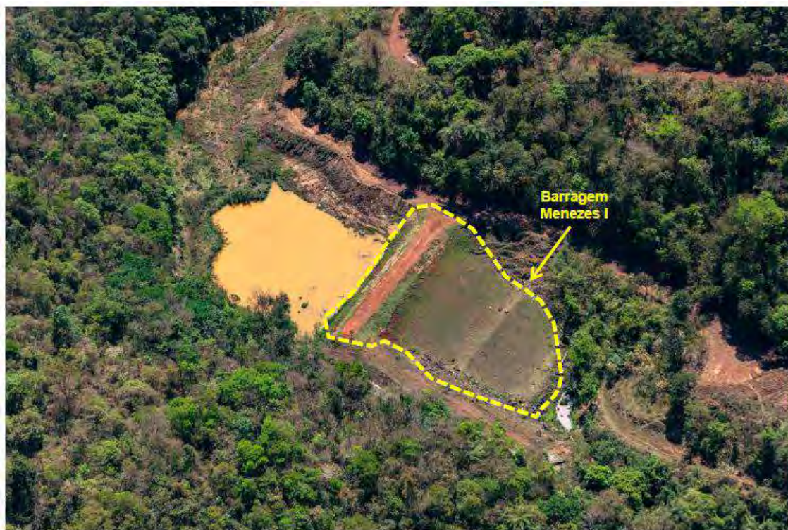
Figura 2.2 – Vista geral da Barragem Menezes I.
