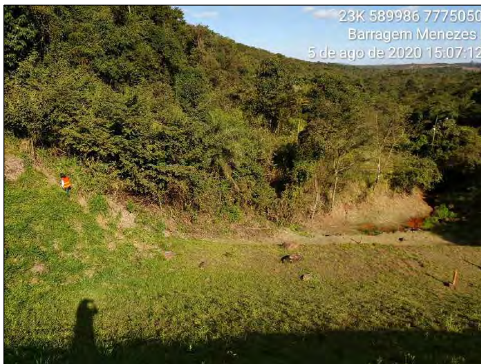
Figura 4-11 – Vista da ombreira esquerda contendo vegetação densa, porém com pouco afloramentos de solo coluvionar.
