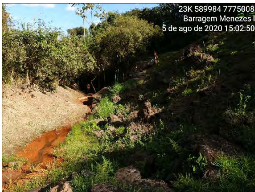
Figura 4-31 – Água com sedimento ferruginoso, aspecto oleoso e presença de finos depositados ao fundo da calha.
