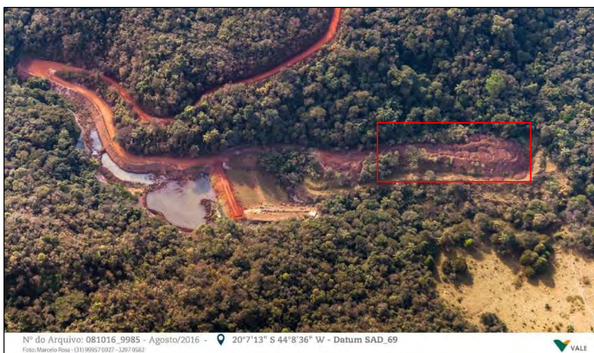
Foto 4.5 - Fotografia aérea evidenciando o material proveniente da limpeza do reservatório (em vermelho), lançado a jusante da barragem.
