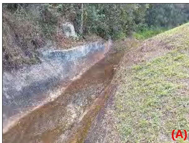
Figura 4-21 – Fotos do extravasor situado junto à ombreira direita: (A) emboque, visto por jusante e (B) canal rápido, visto por montante.
