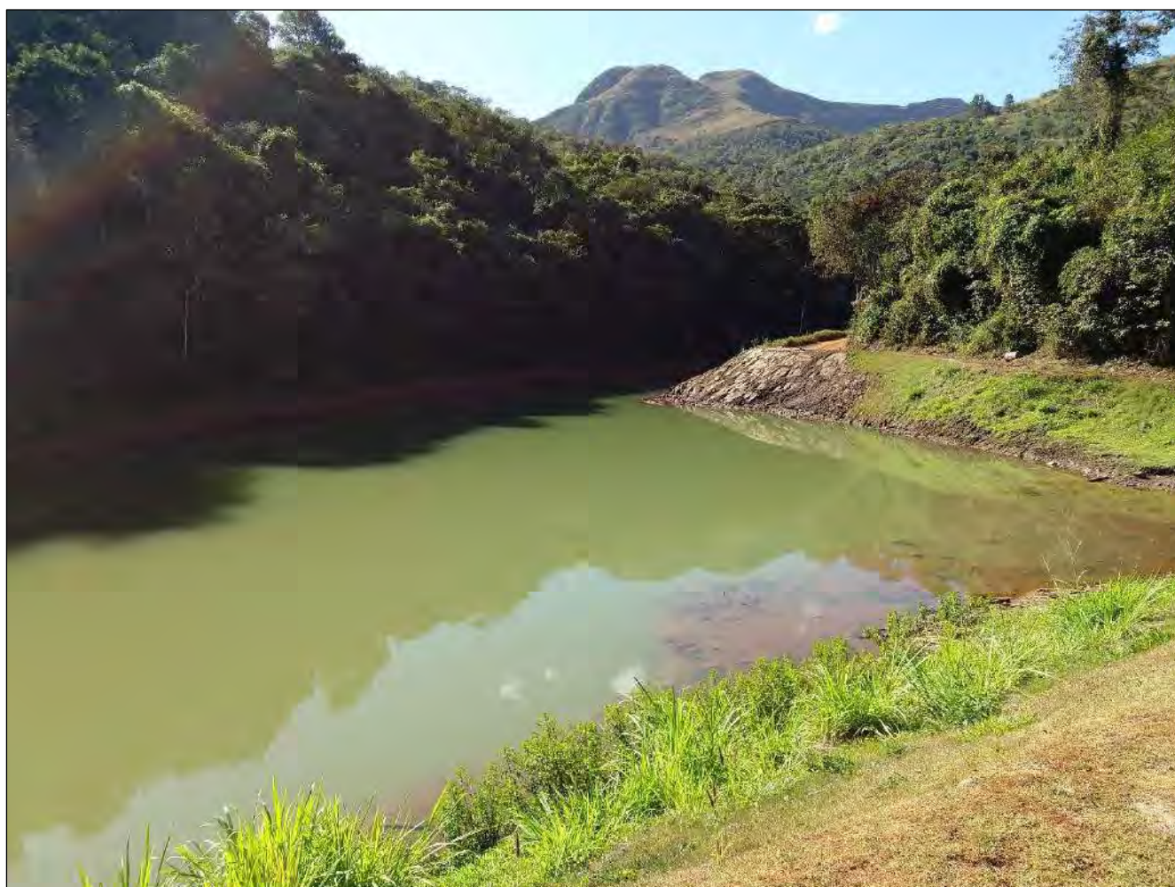
Figura 4-18 – Reservatório da Barragem Menezes I, a partir da crista, próximo à ombreira direita.
