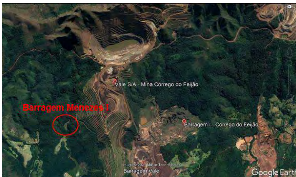
Figura 3.1 – Localização da Barragem Menezes I (Google Earth).
