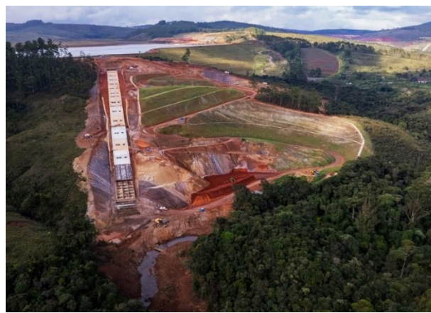
Foto 4: Vista aérea do Maciço da barragem Maravilhas II, Itabirito, Minas Gerais. Fonte: Vale, 2023.
