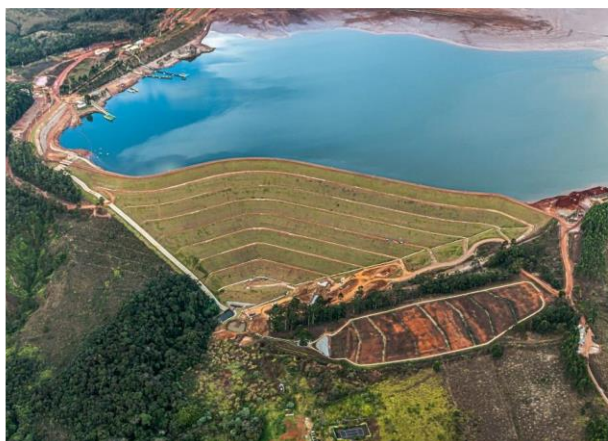
Foto 3: Vista aérea do reservatório da barragem Maravilhas II, Itabirito, Minas Gerais. Fonte: Vale, 2023.
