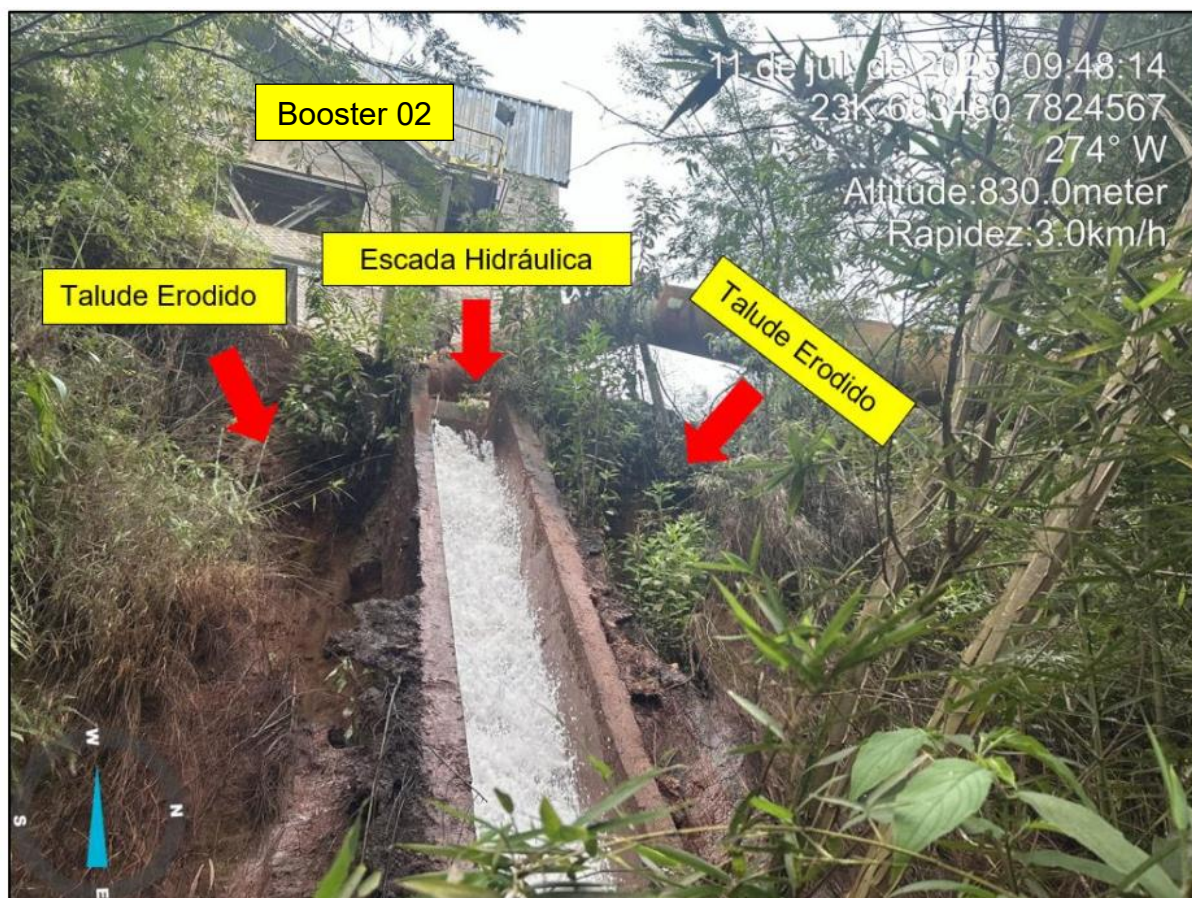
Figura 20. Escada hidráulica e erosão no Talude 1: feições de instabilidade entre o Booster 02 e a Casa de Bombas.
