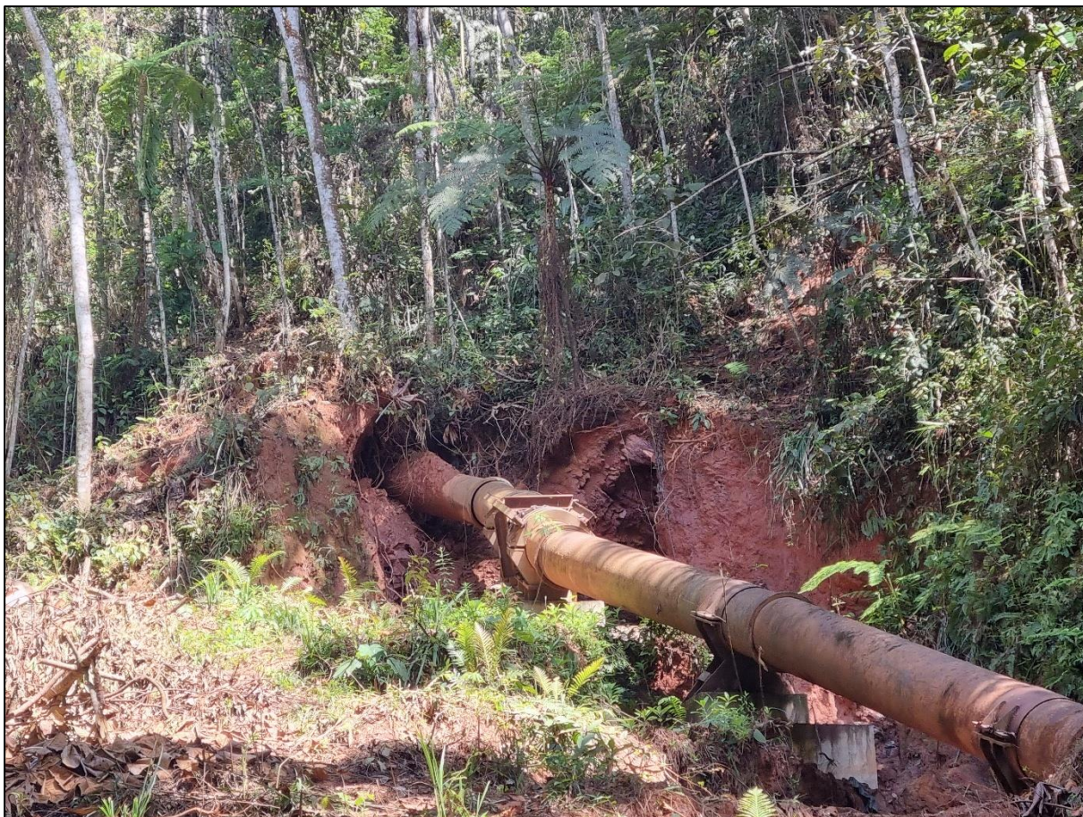
Figura 22. Processos erosivos no Talude 2.
