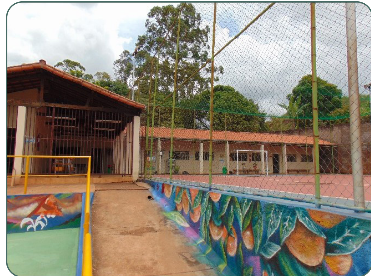
Escola Municipal Eugênio Sampaio, em Córrego dos Pintos.
