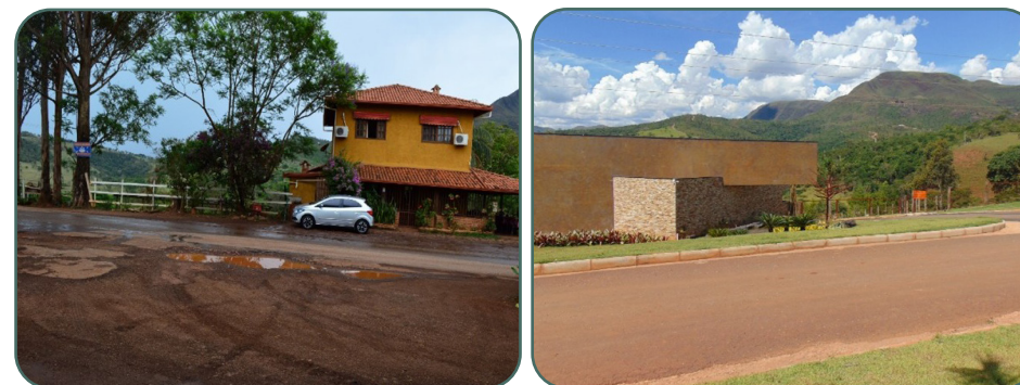
Restaurante Pé de Serra e Entrada do condomínio residencial, em construção
